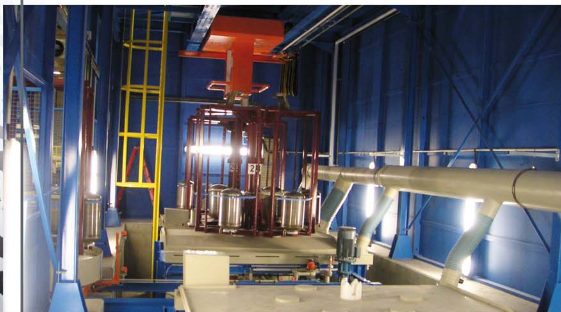
Décapage inox – aspersion corps creux
